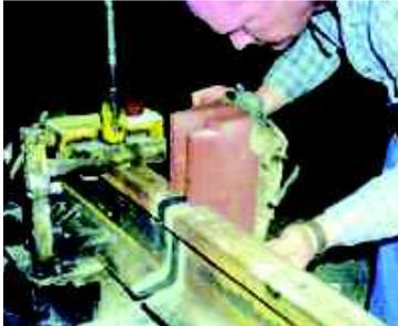
On met en place, autour de la zone à souder, les différentes parties du moule. Le moule est en matériau réfractaire à base de sable siliceux.
